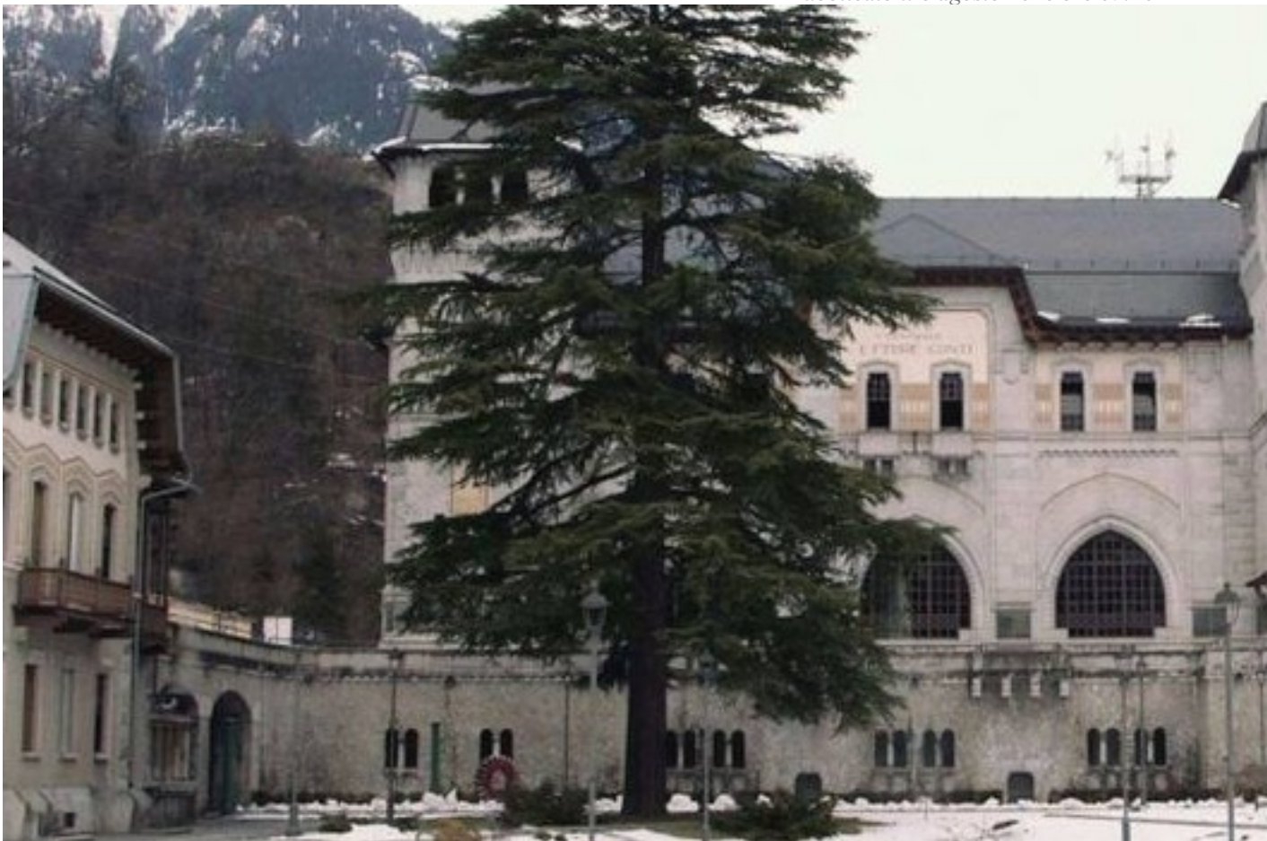
la Centrale elettrica di Verampio, progettata da Portaluppi
